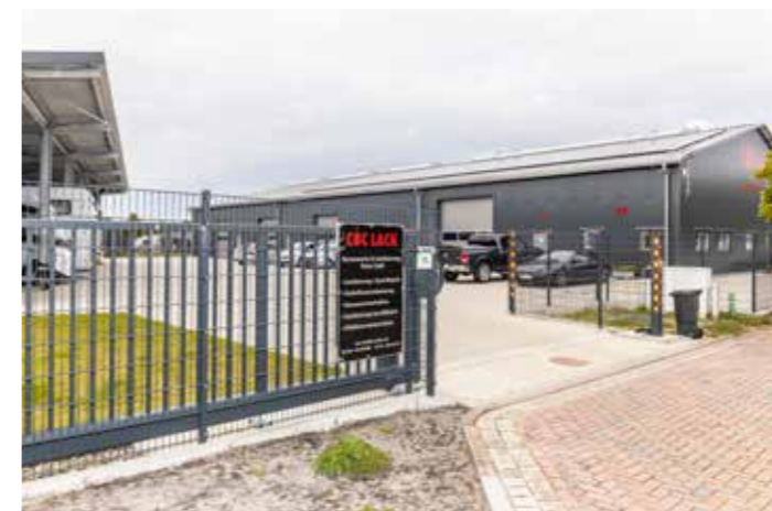
Reichlich Platz: Auf dem 3.000-Quadratmeter-Grundstück steht eine dreiteilige Halle für Werkstatt, Atelier und Oldtimer. Außerdem bietet Saft Mietplätze für Wohnmobile (links).
