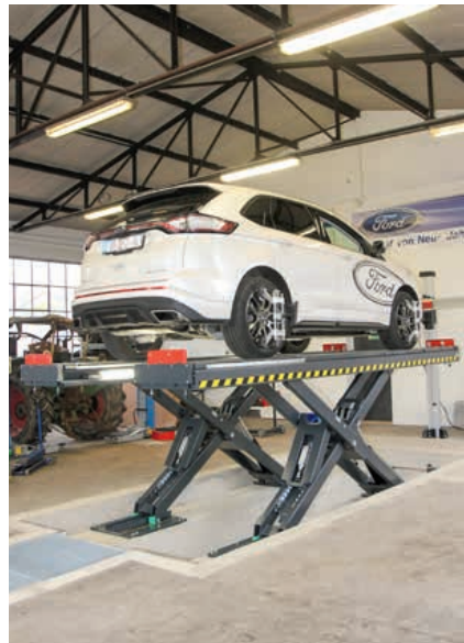
Kompensiert Beschränkungen in der Höhe: Eine Grube schafft maximalen Platz.
