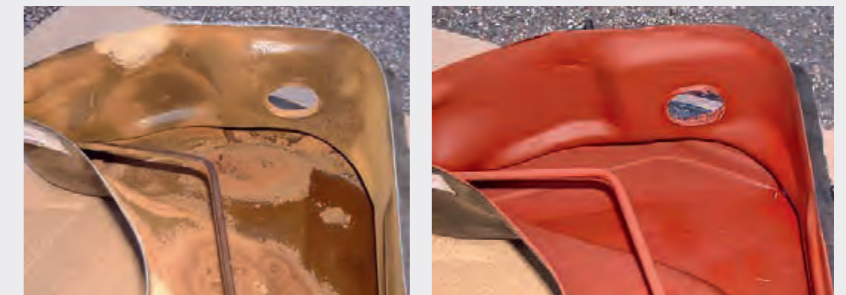
Vorher-nachher-Vergleich: Eine Tanksanierung ist ein schönes Zusatzgeschäft für Werkstätten – und weder übermäßig kompliziert noch besonders zeitaufwendig.
