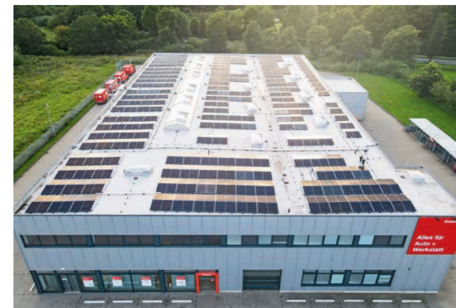
Eigene Stromproduktion, um Geld zu sparen: Matthias hat in vielen seiner Häuser Photovoltaikanlagen aufs Dach gebaut. Hier in Heide wurden auf 900 Quadratmetern 462 Module installiert.
